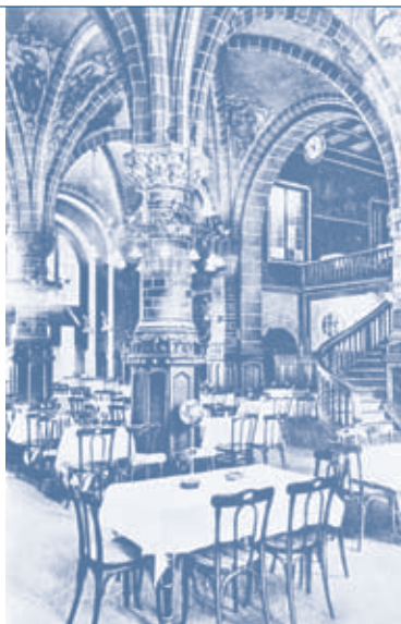
Restaurant: Ansicht mit Blick zum Gelben Zimmer im früheren Haus der Kölner Bürgergesellschaft AG
